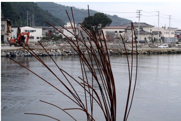
「町のいたるところに電信柱の鉄筋が」
