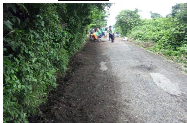
「完成！後はアジサイを植えるのみ」 2011年6月28日 塩釜市浦戸桂島にて
